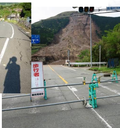
大きく崩れた山肌
